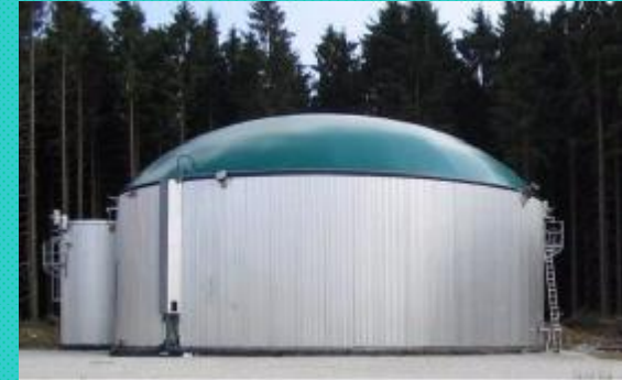
3 Biogasanlagen in Karow, Oehna und in Vosshöhlen, Strom für ca. 4.000 Haushalte
